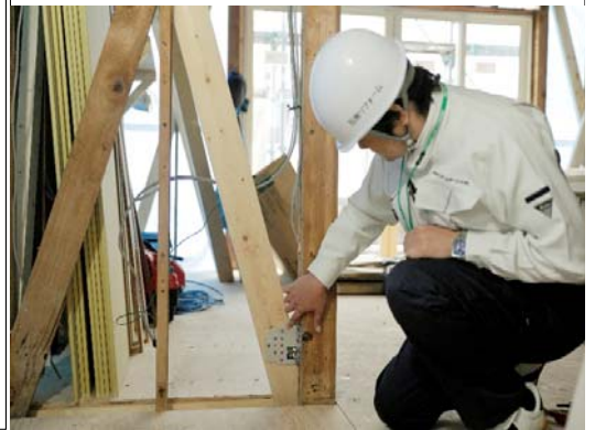
工事中間検査
