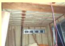
外壁断熱工事の例
