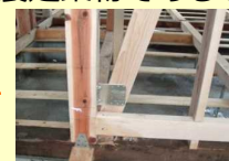
耐震補強工事の例
