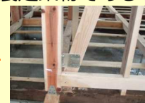
耐震補強工事の例
